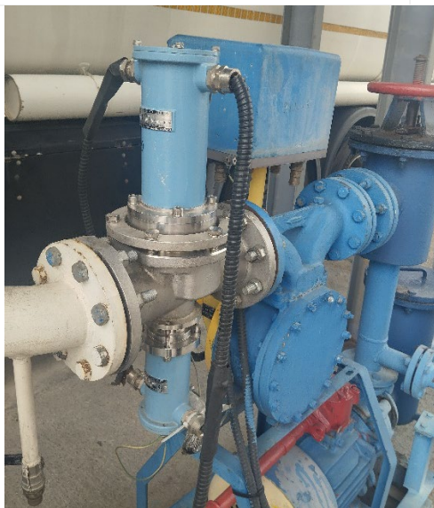
Рис. 1в. Клапан СЕНС-ПР с номинальным диаметром 80. Общий вид
